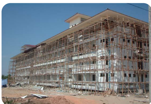
ก่อสร้างอาคารหอพัก
